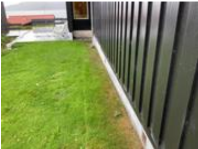
Terreng med fall mot mur.
