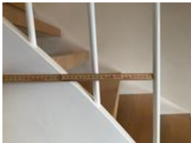
Større åpninger mellom spiller i rekkverk.
