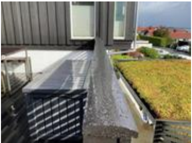
Skjevt rekkverk.
