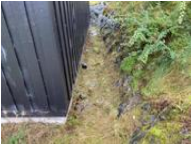
Terreng med fall mot mur.
