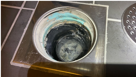
Sluk i vaskerom
