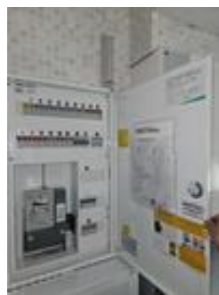
Sikringskap med automatsikringer og kursfortegnelse
