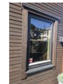
Vinduer med karmen av tre og tre lag isolerglass
