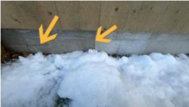
Ikke tett mellom elementene og det er en skade.
