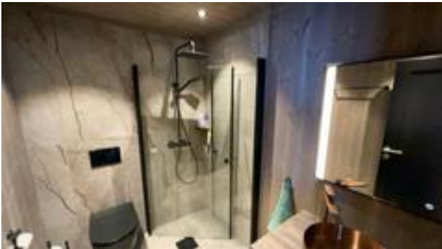
Det er en kombinasjon av fliser og panel i våtsonen.
