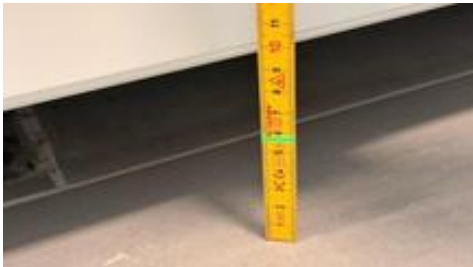
Gulv foran sluk
