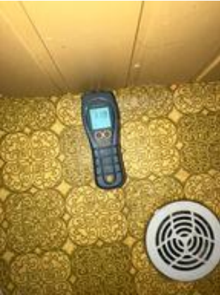
Bilde av fuktsøk i organisk materiale i dusjsone uten at det registreres skadelig fukt.
