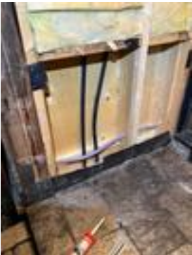
Åpen vegg uten tegn til skade bak dusjsone
