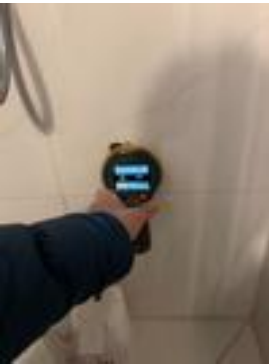
Ingen unormale utslag med fuktindikator på dusjvegger
