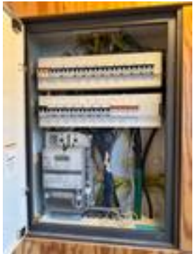
Automatsikringer med skap i entre.
