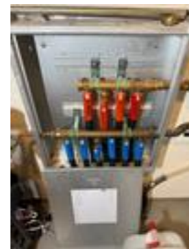
Rørskap i teknisk rom/døren går ikke på
