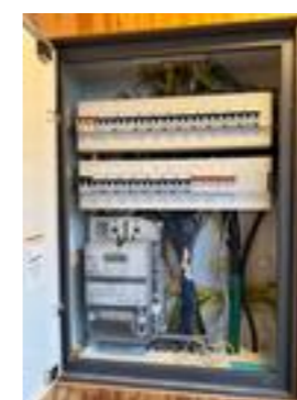
Automatsikringer med skap i entre.
