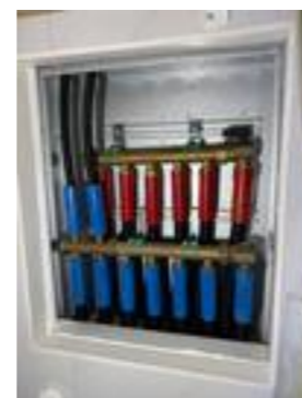
Rørskap i teknisk rom/døren går ikke på
