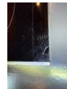
Det bemerkes sprekke i hjørne på platetopp.
