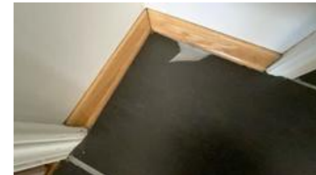
Bit av flis som er knekt av. Området er fuget.
