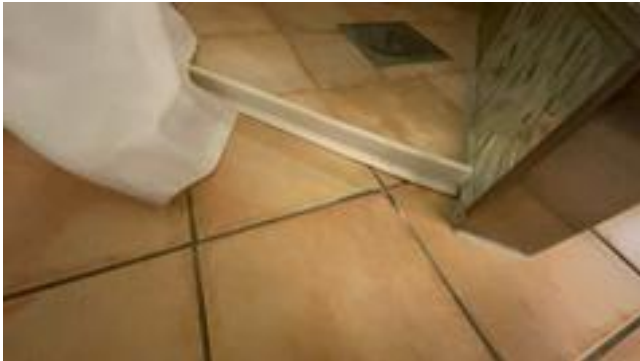
Det er tett terskel inn til sluk i dusjonen.
