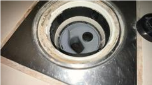
Sluk under innredning på vaskerommet.
