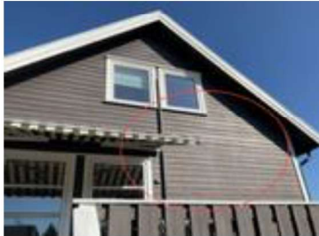
Slitasje/oppsprukket kledning.
