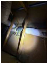
Tidligere utett kanal, kan være årsaken til misfargingen.
