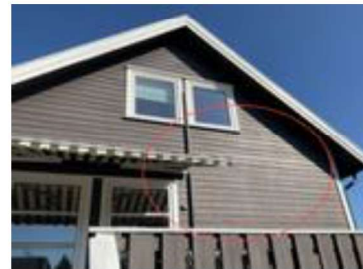
Slitasje/oppsprukket kledning.
