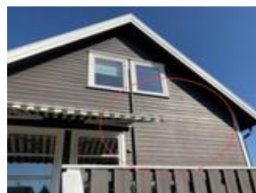
Slitasje/oppsprukket kledning.
