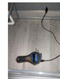
Måling av RH i hulrom viser akseptabelt nivå.
