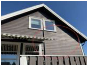
Slitasje/oppsprukket kledning.
