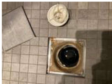
Sluket i dusjsonen-Synlig banemembran
