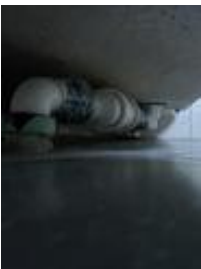
Avløp under kabinett utført med tape, og ført ned i avløpsrør.
