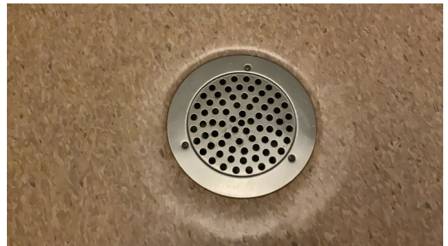
Sluk i gulv.
