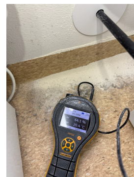
Fuktsøkt i vegg uten unormale forhold.
