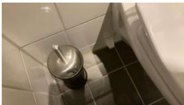
Drensåpning fra toalettasse.
