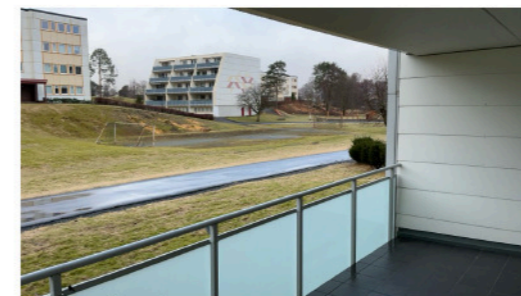
Rekkverk av stål og glass.
