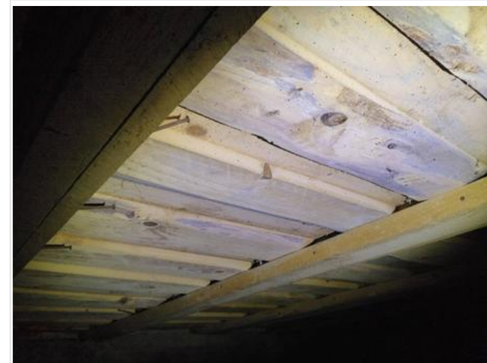
Spor etter stripet borebille i store deler av grovkjeller.
