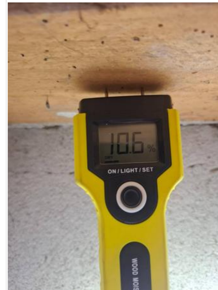
10,6% vedfukighet i den nyere delen av kjelleren fra 60 tallet.
