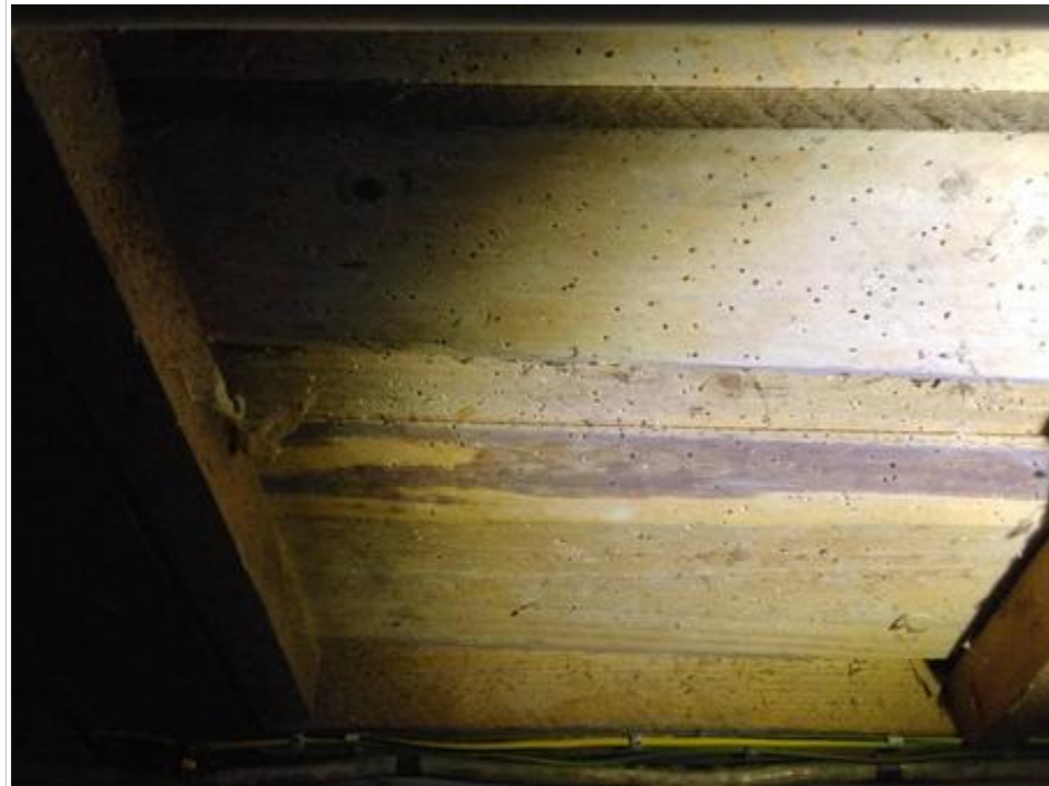
Spor fra stripet borebille i store deler av grovkjeller
