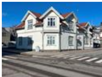
Den eldste delen av bebyggelsen, ut mot krysset.
