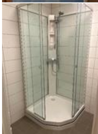
Nyoppusset bad i en leilighet.
