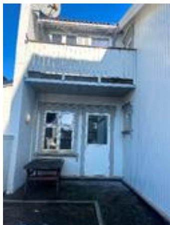
Uteplass i første etasje, og veranda i andre etasje.
