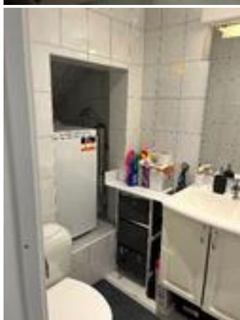
Eksempel på bad i andre etasje i eldre del.
