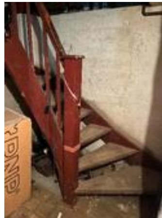
Innvendig trapp til kjeller i eldre del.
