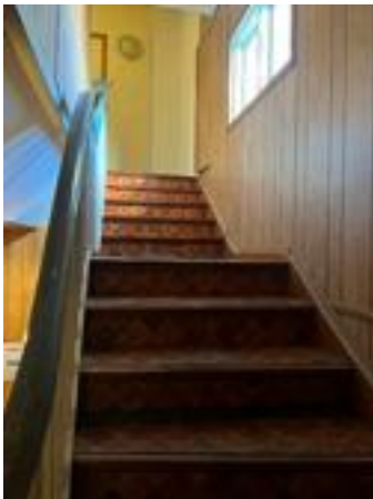
Innvendig trapp til andre etasje i eldre del.
