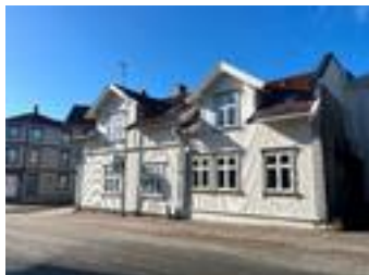
Tilbygget fra 2004, med fasade mot Sverres gate.
