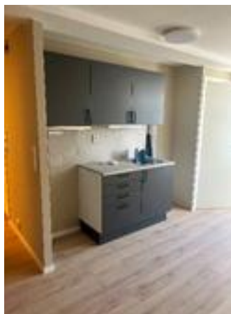
Ny kjøkkeninnredning i den ene leiligheten.
