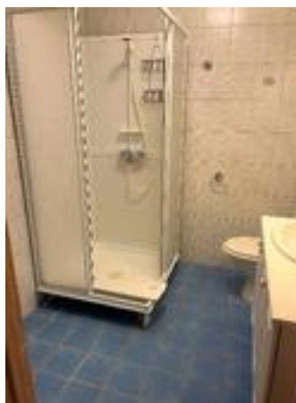
Bad med dusjkabinett.
