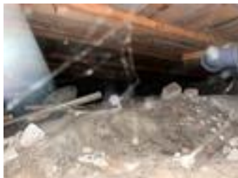
Det er krypkjeller under deler av huset.
