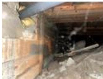
Det er krypkjeller under deler av huset.
