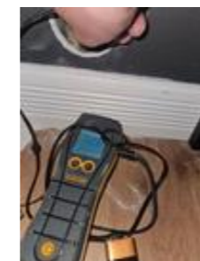
Ingen indikasjon på unormal fukt i veggen
