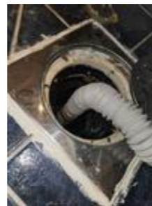
Plastsluk med mansjett og klemring
