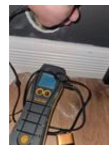
Ingen indikasjon på unormal fukt i veggen
