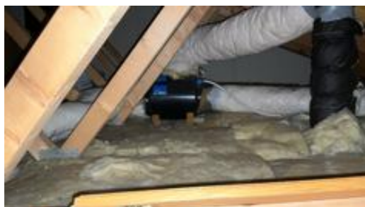
Avtrekkshifte på loft.
