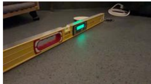
Gulvets fall er kontrollert med elektronisk nivåaser og elektronisk vater. U- ETASJE > VASKEROM 3,43 M2
