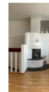
Muret elementpeis med lukket peisinsats. Skorstein av pipeelementer.
