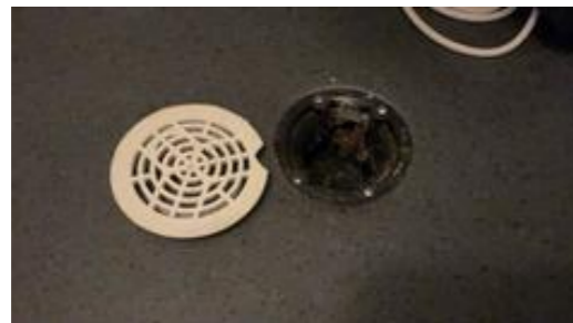
Eldre plastsluk med nytt belegg. Klemring montert. U- ETASJE > VASKEROM 3,43 M2
