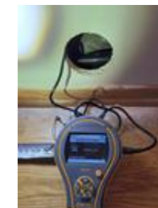
Fuktmåling mot våtsone bad
