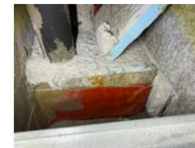
Synlig banemembran i gulv.
