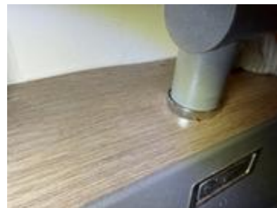
Svelling i benkeplate ved kjøkkenkran
