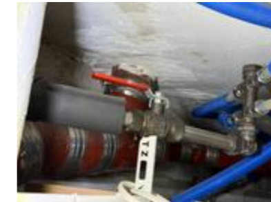
Rørøpplagg og stoppekran bak luke i badromshimling
