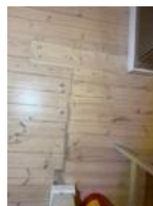
Innskjøtet gulv på kjøkken etter fjerning av vegg.
