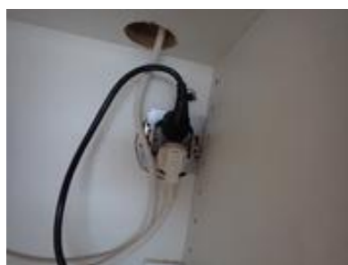
Stikkontakt mangler deksel i overskap til venstre for kjøkkenvifte. Det er risiko for berøringsfare og fare for liv og helse.
