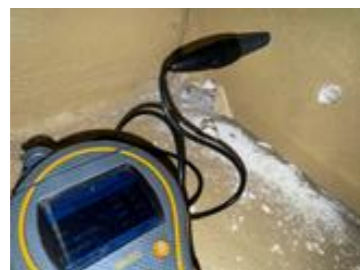
Måling av relativ luftfuktighet i lukket veggkonstruksjon mellom gang og dusjsone
