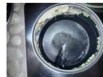
Kontroll av sluk. (Hjelpesluk)
