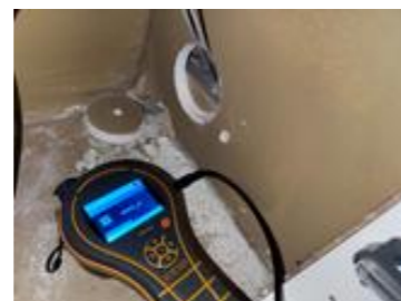
Måling av trefukt i lukket veggkonstruksjon mellom gang og dusjsone
