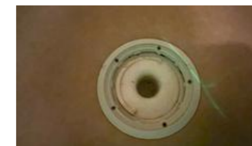
Sluk i gulv og synlig vinylbelegg som tettesjikt.
