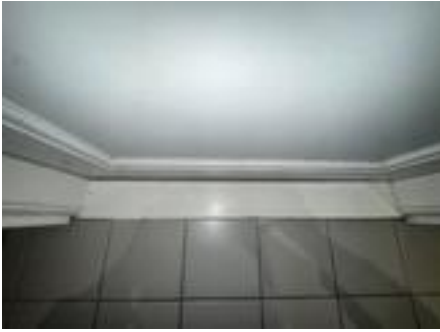
Begrenset luftespalte når døren er lukket.
