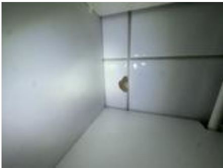
Sår i flis bak servantskap
