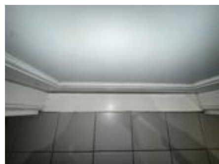
Begrenset luftespalte når døren er lukket.
