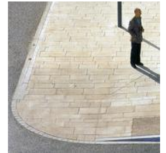
Universell utforming, her eksemplifisert ved en myk overgang mellom gate og fortau.
