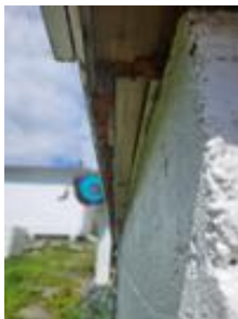
Lite eller ingen lufting langs nedre kant av bordkledningen
