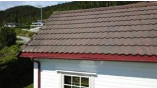
Taket er tekket med profilerte metallplater
