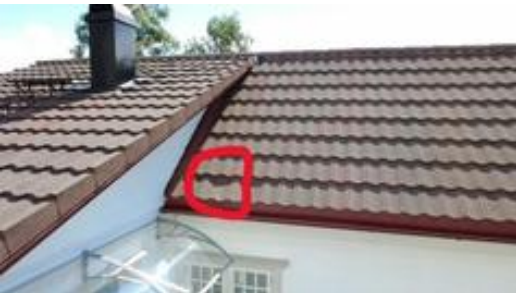
Markert en bulk på en takplate.
