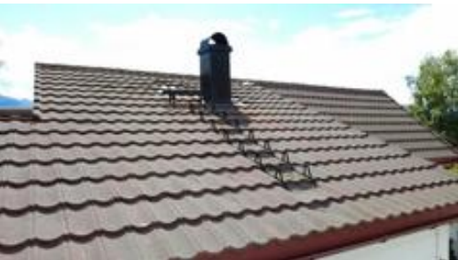
Takstigen rekker ikke helt ned til takfoten
