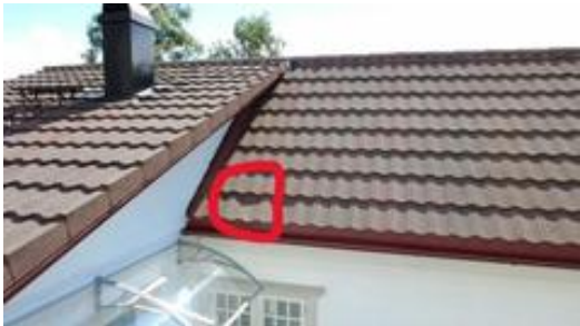
Markert en bulk på en takplate.
