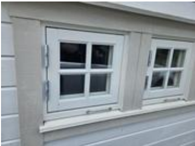
Vinduer av nyere dato, med koblete glass
