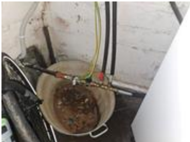
Stoppekran og reduksjonsventil for vann, i kjelleren
