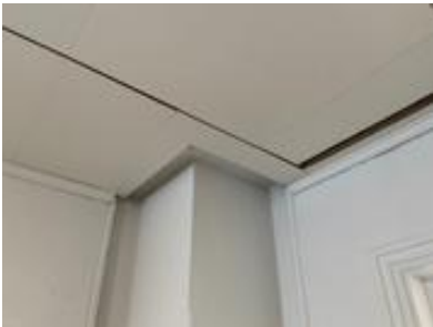
Gjenstående arbeider i himling.
