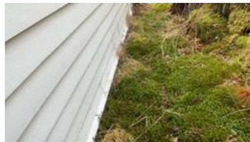
Bordkledningen går ned til terreng.
