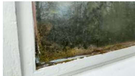
Vindu i kjeller.
