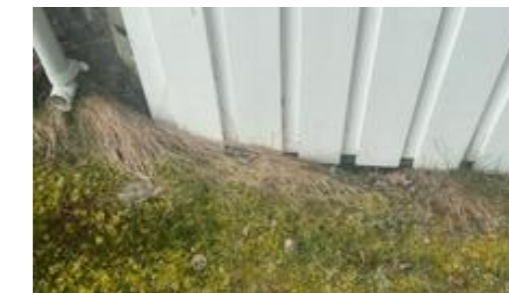
Bordkledningen går ned til terreng.
