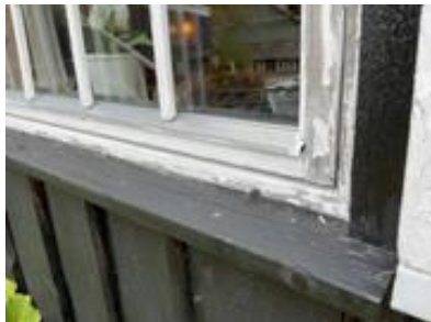
Værslitasje/malingflass enkelte.
