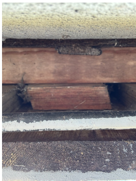
Slått klosse under/bak overligger.
