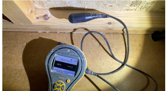
Fuktsøkt i vegg uten unormale forhold.
