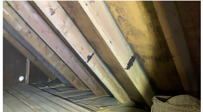
Svertesopp på undertak/sutak.
