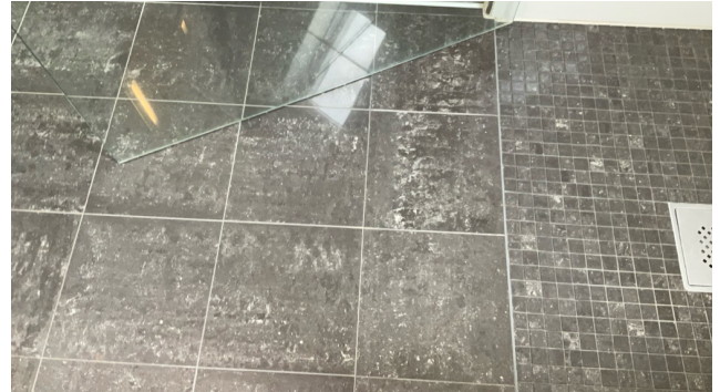
Bl.a knikk/bom under fliser i dette området på gulv.
