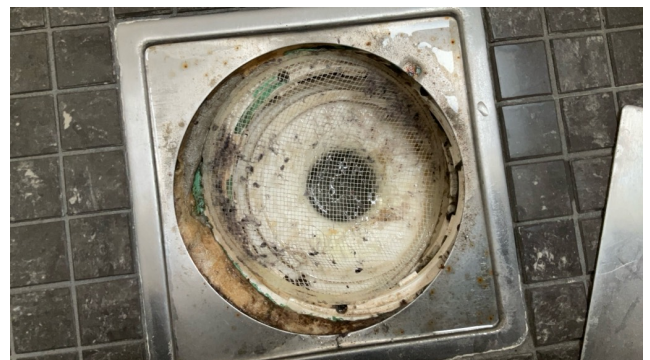
Sluk i gulv.
