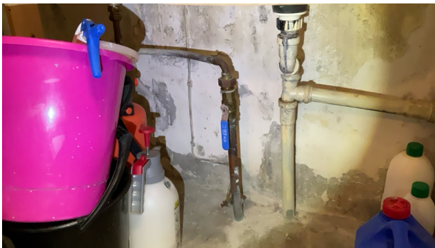
Stengekran på vann.
