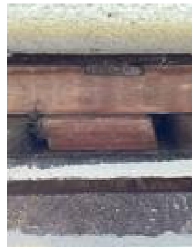
Slått klosse under/bak overligger.
