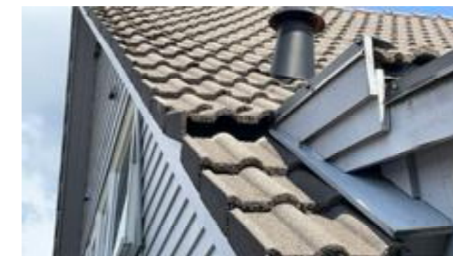
Ikke tilpasset gavlestein mot innglassing.
