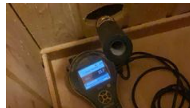
Fuktsøkt i påforet yttervegg uten unormale forhold.
