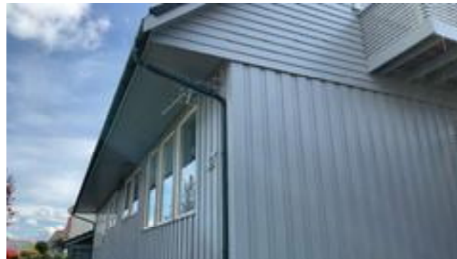
Stående og liggende bordkledning.
