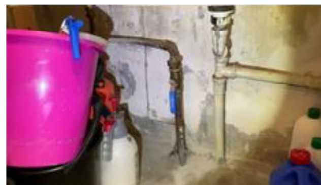
Stengekran på vann.
