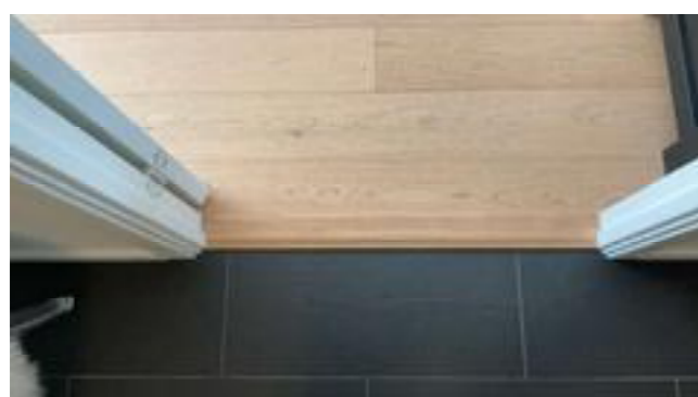
Fliser og parkett på gulv.
