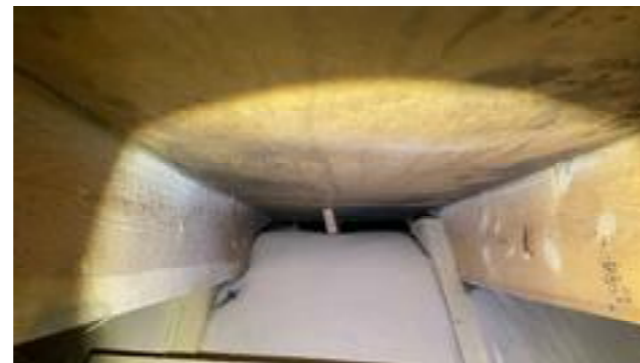
Trekk lekter ned mellom isolasjonen og undertak.
