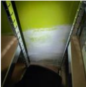
Kalkutslag i bod mot nordøst.
