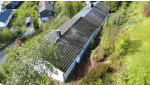
Takflate mot nord.
