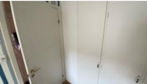
Pipe er innekledd på 3 sider i 2.etasje.
