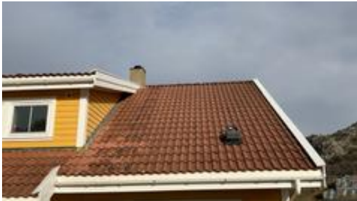
Betongtakstein fra byggeåret.
