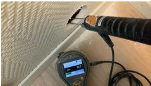
Fuktsøkt i påforet yttervegg uten unormale forhold.
