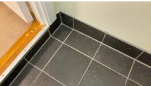
Bl.a ett område på gulv med bom/hullyd under.
