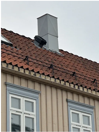
Skorstein kledd med beslag.
