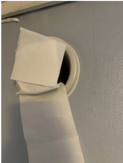
Funksjonstest med papir av ventilasjon.
