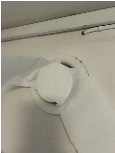
Funksjonstesting av ventilasjon med papir.
