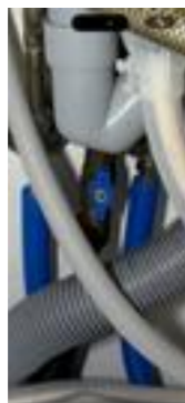
Blå hovedstoppekran i kjøkkenbenk.
