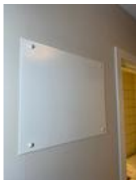
Rørskap på utsiden av badet.
