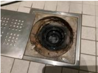
Plastsluk med slukmansjett og klemring
