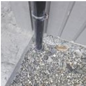
Takkvannet ledes til rør i grunnen
