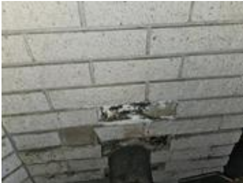
Brannmur og røykrør, ikke i bruk
