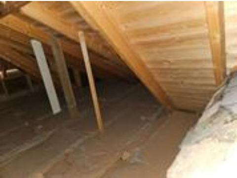
Deler av loftet er isolert
