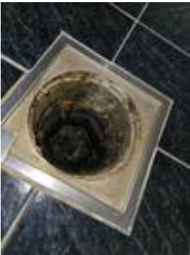
Plastsluk, trolig fra 70 tallet. Gammel klemring men ikke synlig membran eller mansjett.
