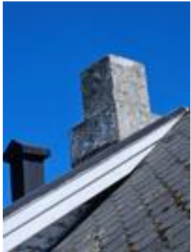
Brannmur og røykrør, ikke i bruk
