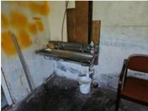
Vaske- renne på veggen
