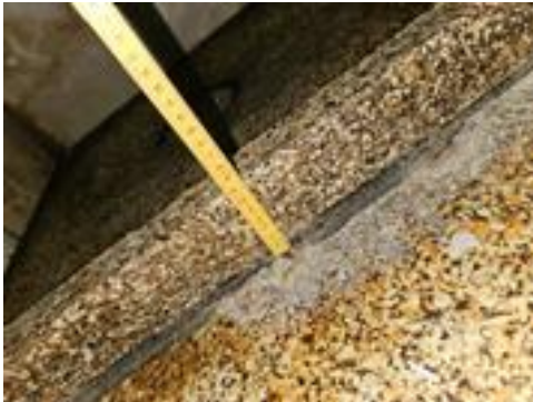
Oppkant rundt dusjnisjen med sluk, høyere enn dørstokken
