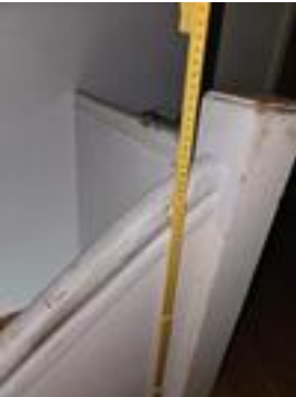
Rekkverket ble målt til ca 64 cm høyde
