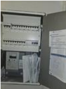
Sikringsskap med automatsikringer og kursfortegnelse
