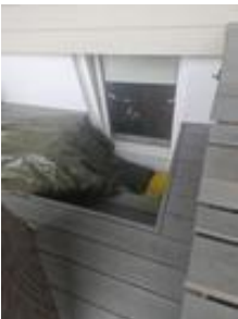
Vindu med lysgrav, mot kjellerstue
