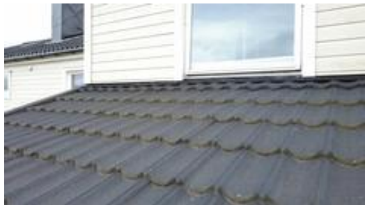
Taket er tekket med profilerte metallplater
