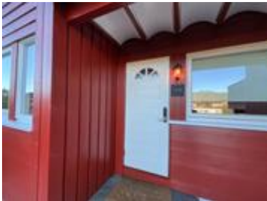
Ytterdør er beskyttet av overbygg (altan).
