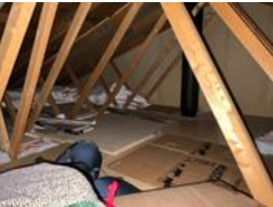
W-takstoler og ikke bærende undertak.
