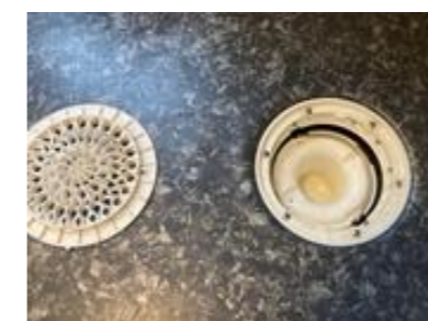
Sluk på golv v/opplegg for badekar
