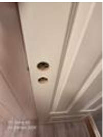
Det mangler dørvrider på en dør i hybel.
