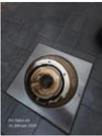
Sluk med synlig slukmansjett og klemring.
