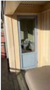
Balkongdør med alum. bekledning.
