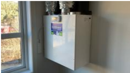
Ventilasjonsaggregat.
